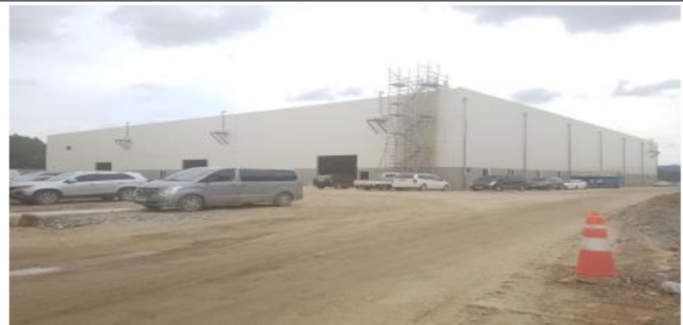
초전도조립동 (내부 마감 공사)
