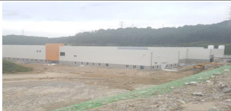
SRF시험동 (내부 마감 공사)
