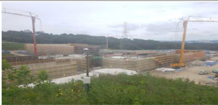
저에너지AB구역 (B1F 벽체 철근배근 및 Conc 타설)
