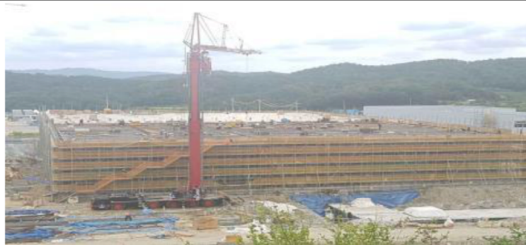
유틸리티동 (1F 벽체 철근배근 및 Conc 타설)
