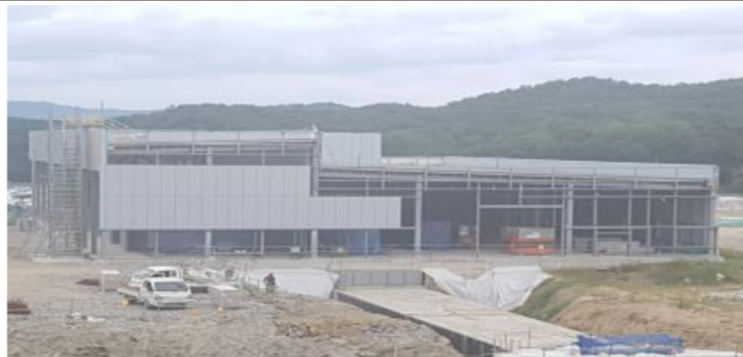
수전설비동 (하지철물 설치)
