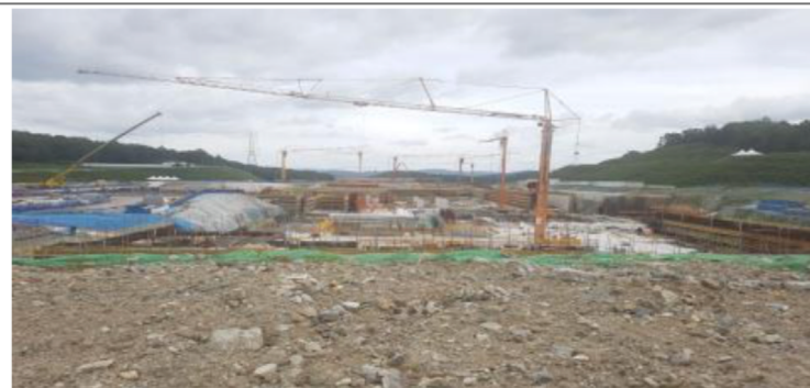
고에너지B구역 (B1F 벽체 철근배근 및 Conc 타설)
