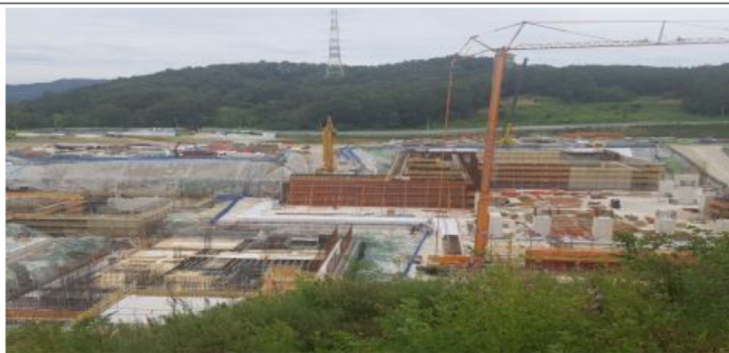
IF/고에너지A구역 (B1F 벽체 철근배근 및 Conc 타설)
