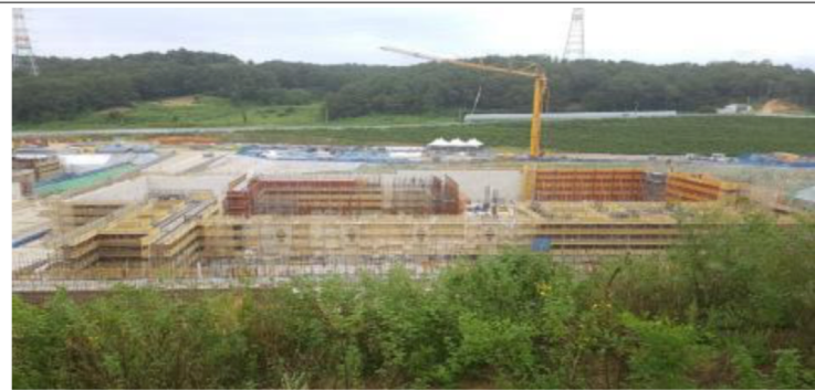
ISOL구역 (B1F 벽체 철근배근 및 Conc 타설)
