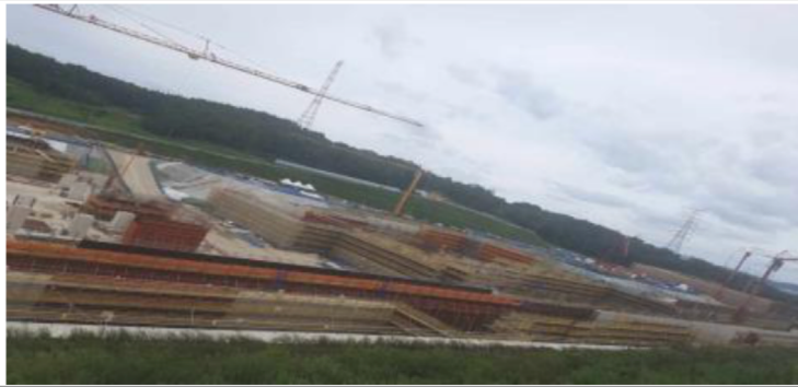
SCL2구역 (터널 벽체 철근배근 및 Conc 타설)
